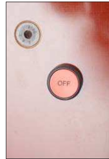
图 18 - 线圈前面的紧急停止按钮
